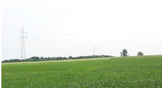
Fotografia 13. Słupy linii wysokiego napięcia Fot. własna 01.06.2016
