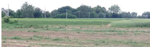
Fotografia 14. Słupy linii niskiego napięcia Fot. własna 01.06.2016
