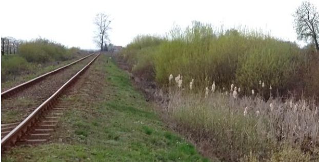
Fotografia 17. Tory kolejowe Fot. własna 14.04.2016
