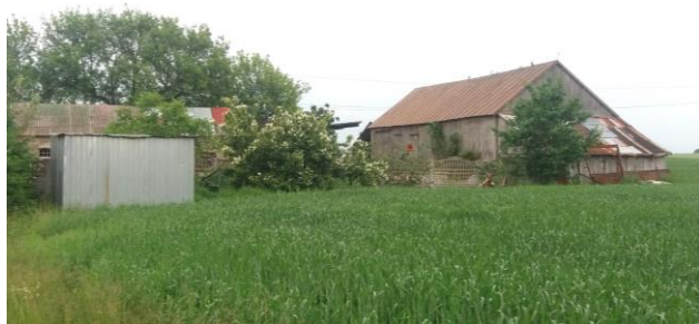
Fotografia 7. Zabudowa zagrodowa Fot. własna 01.06.2016
