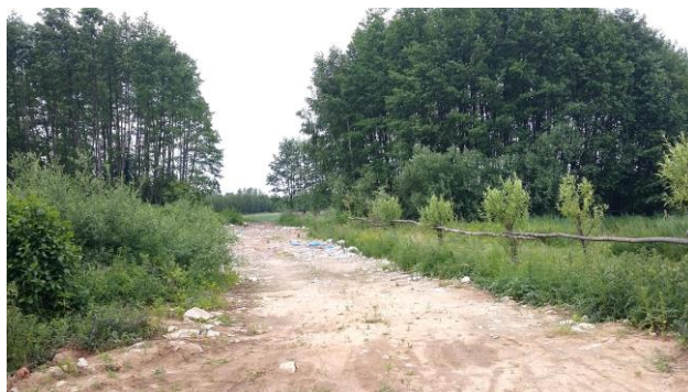
Fotografia 16. Droga wykonana z odpadów budowlanych Fot. własna 01.06.2016
