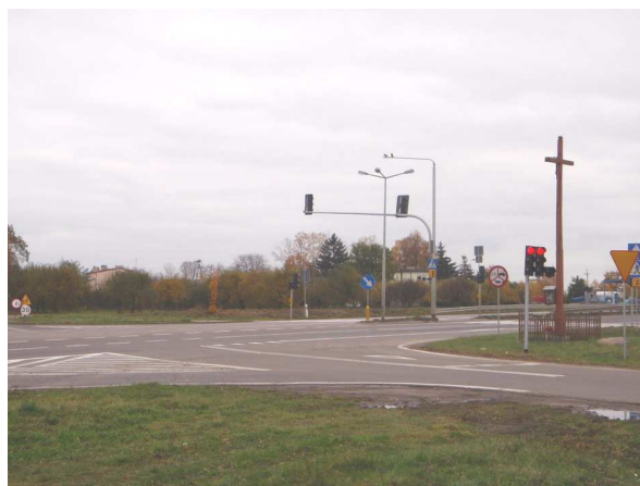
Skrzyżowanie drogi lokalnej z krajową nr 7
